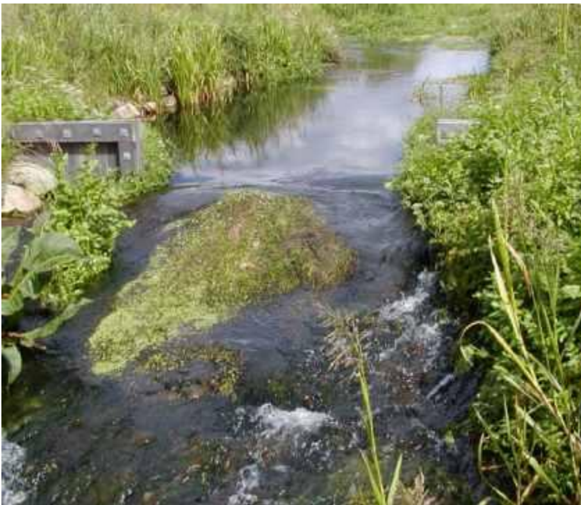
Vandstanden i mosen er hævet ved at der i udløbet af Almstrup kanal er bygget et spunsværk.
